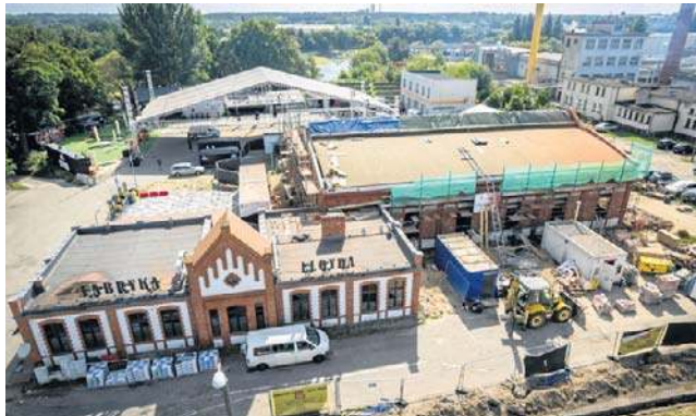
Trwa odbudowa spalonej Fabryki Lloyd
