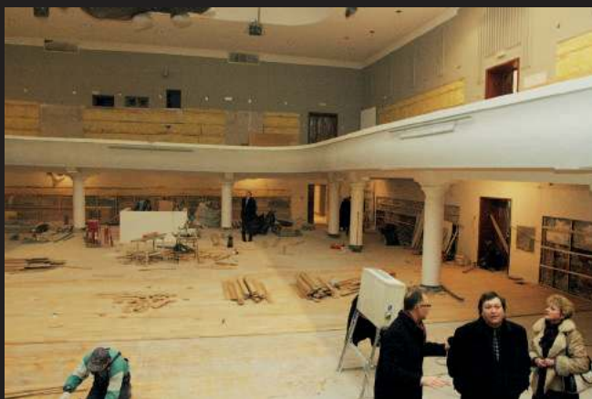
Wielki remont RCK: sala widowiskowa bez widowni
