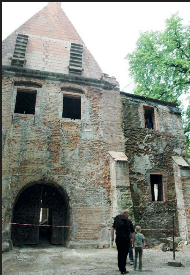
Brama wejściowa na Zamek Piastowski jeszcze przed remontem
