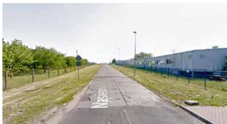
Na ulicy Nasiennej powstanie nowy ciąg pieszo-rowerowy
