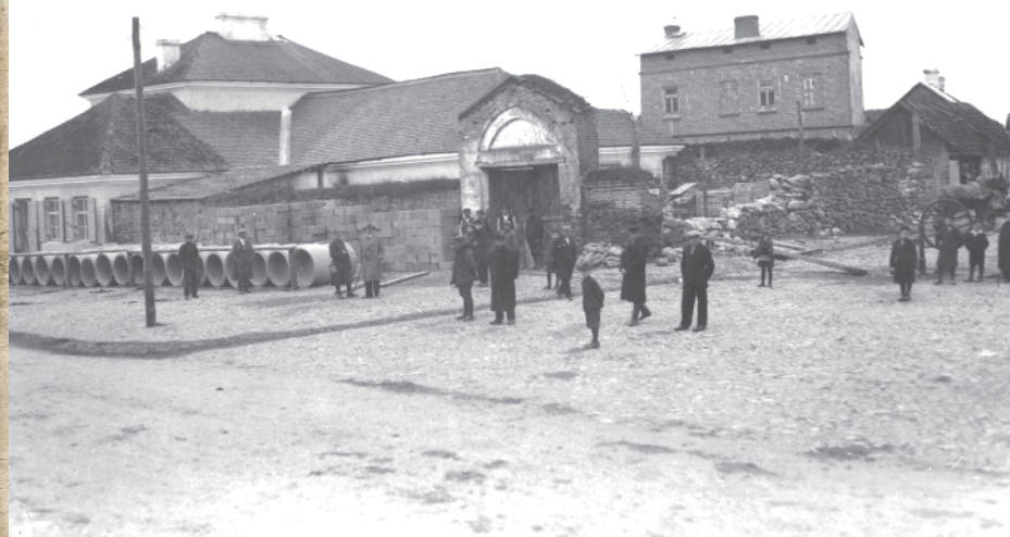
Zdjęcie wykonane około roku 1930 (według Narodowego Archiwum Cyfrowego) Budynek miał najprawdopodobniej duże podziemia, istniały przekazy o daleko sięgających korytarzach. Zbudowany w XVIII wieku, zniszczony został razem z całym niemal miastem przez Niemców we wrześniu 1939 roku - w bezmyślnym akcie barbarzyństwa spłonęło też archiwum i cenny księgozbiór. Obecnie zachowała się tylko jedna ściana, przylegająca do pomieszczeń Ochotniczej Straży Pożarnej
