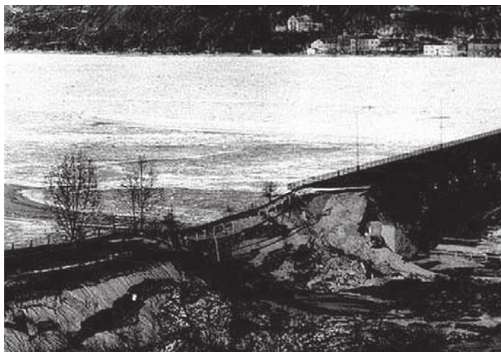
Zarwany most drogowo-kolejowy na Wiśle (1982)
