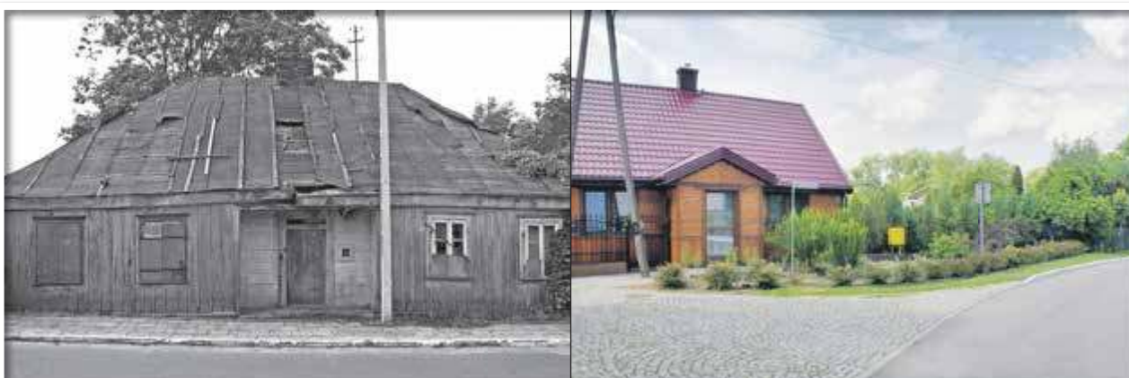
Nowa zabudowa przy ul. kardynała Stefana Wyszyńskiego stopniowo wyparła stare, niejednokrotnie pamiętające początek ubiegłego wieku drewniane budynki
