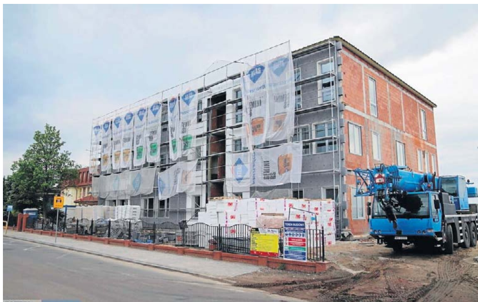
Prace przy budowie nowego budynku dydaktyczno-warsztatowego zbliżają się do końca
