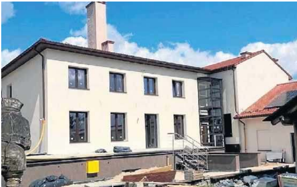
Dom Kultury w Zwoleniu pięknie z dnia na dzień. Po remoncie będzie ocieplony i gruntownie odnowiony.
