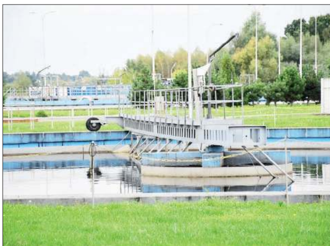
Część inwestycji na oczyszczalni została sfinansowanych dzięki środkom Wojewódzkiego Funduszu Ochrony Środowiska i Gospodarki Wodnej w Katowicach
