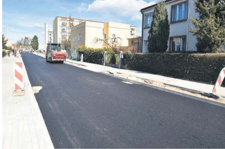
We wtorek pierwszą warstwę masy bitumicznej wylano na ulicy Kościuszki. Zgodnie z zapewnieniem wykonawcy do końca tygodnia ma ona zostać położona także na części Grunwaldzkiej i Piastowskiej.
