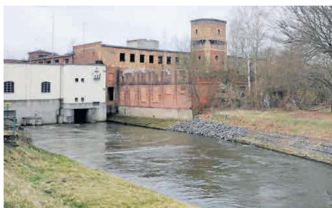
Wyspa powstała za sprawą dodatkowego koryta Nisy Łużyckiej, które doprowadzało wodę do elektrowni
