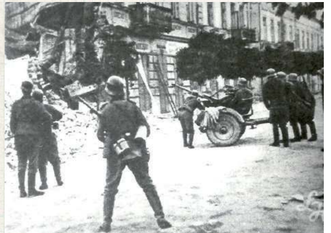
Zniszczona w bombardowaniu we wrześniu 1939 kamienica przy ulicy Piłsudskiego 4 w Łukowie. W jej piwnicy zginęło około 40 osób, w dużej części uciekinierów z innych miast
