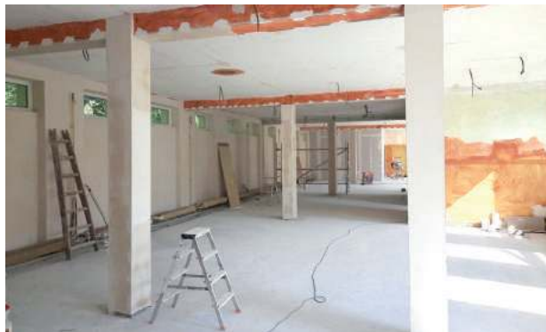
Remont szatni dla osób niepełnosprawnych w SP nr 6 idzie pełną parą. Tak obecnie prezentują się pomieszczenia. Wszystko ma być gotowe do końca października
