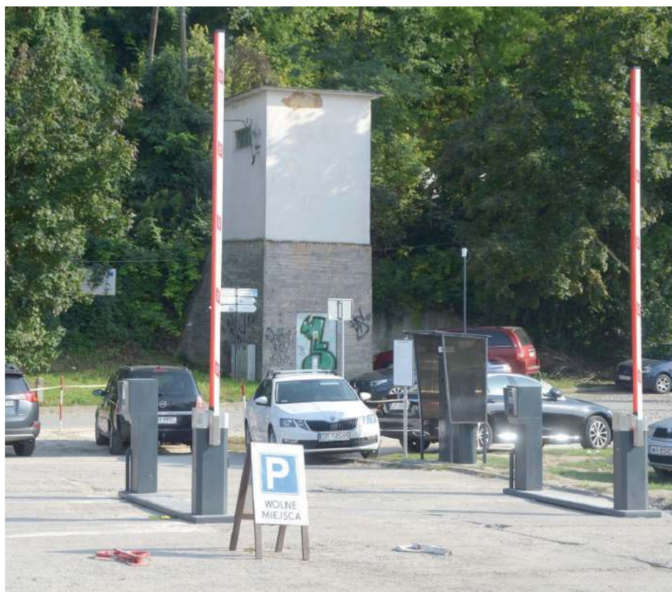
Szlabany umożliwiające wjazd na teren parkingu zostały już zamontowane
