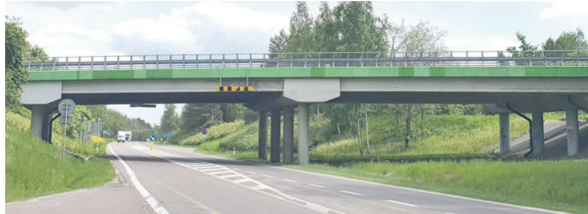
Wiadukt na ul. Domanickiej będzie zburzony.
