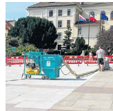
Roboty na miejscu ruszyły w poniedziałek, 7 września
