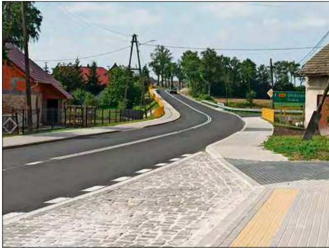
Są nowe elementy zwiększające bezpieczeństwo ruchu – wysepki spowalniające ruch, punktowe elementy odblaskowe, płyty integracyjne, bariery energochłonne.
