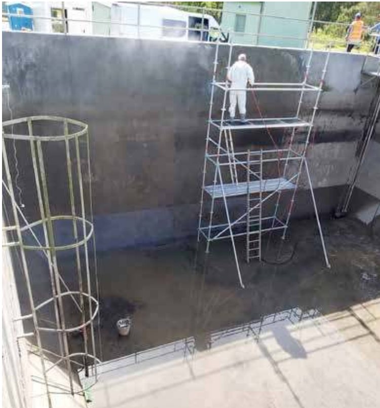
Prace w oczyszczalni zostały zakończone (fot. Gm. Przybiernów)
