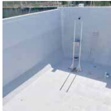
Zmodernizowano oczyszczalnię ścieków (fot. Gm. Przybiernów)
