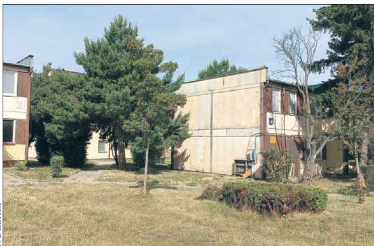
Wkrótce urząd miasta planuje ogłoszenie przetargu na wyburzenie starego budynku przy ulicy Miodowej 33 i budowę nowego obiektu
