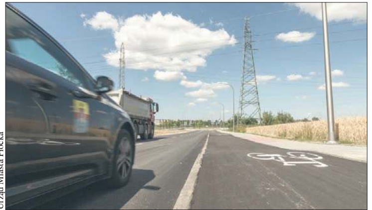
Urząd Miasta Płocka Prace na ulicy Zbożowej trwały cztery miesiące
