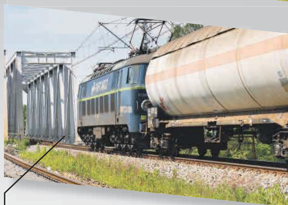
Odnowione przesłone mostu na Kanale Gliwickim
