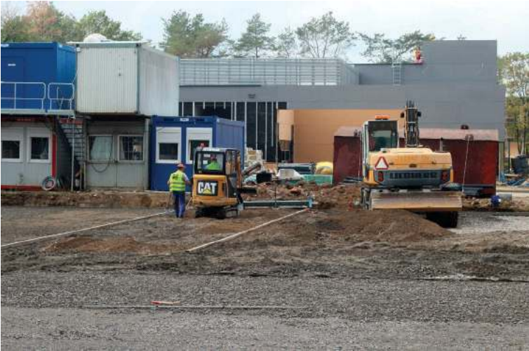
Budowa „Parku Avia” idzie „pełną parą”
