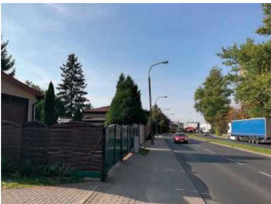
Przechylające się coraz bardziej latarnie niepokoją mieszkańców ul. Krańcowej
