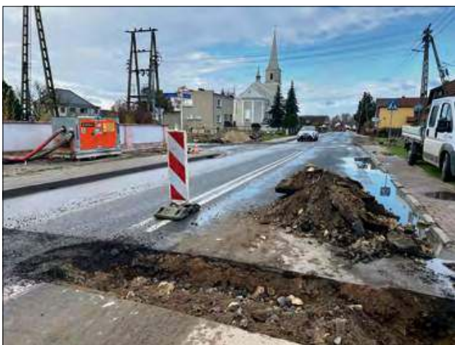
Wciąż nie wiadomo, kiedy droga wojewódzka w Obrowcu zostanie przebudowana.
