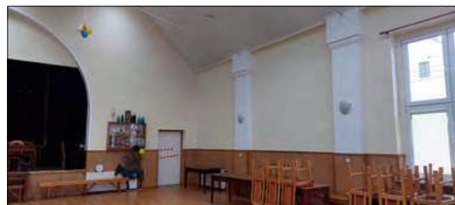
Ściany Domu Kultury w Kujawach zostały odmalowane.
