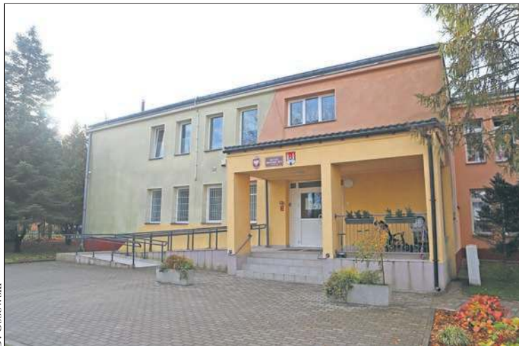
Budynek Miejskiego Przedszkola nr 14 w Płocku
