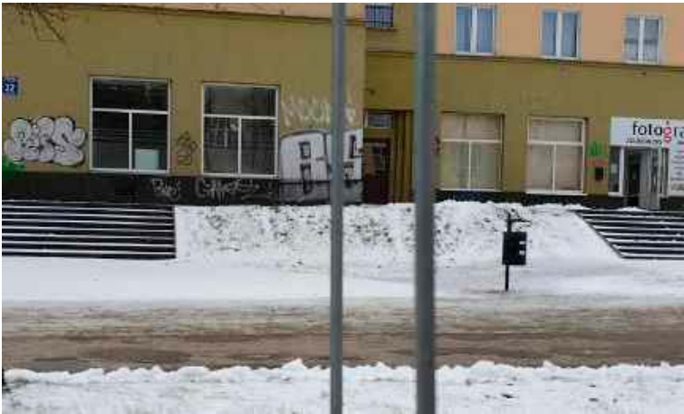
W ramach dodatkowych prac wykonano m.in. remont schodów i ciągów pieszych wzdłuż budynku przy Al. Raclawickich 22
