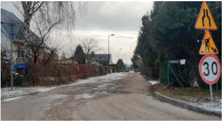
W ubiegłym tygodniu drogowcy zwrócili na ulicę Działkowca część potrzebnych materiałów i oznakowali budowę. Same roboty ruszą lada dzień
