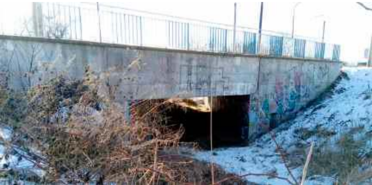
Niedokończone podziemne przejście pod ul. Orkana na wysokości skrzyżowania z ul. Szaserów
