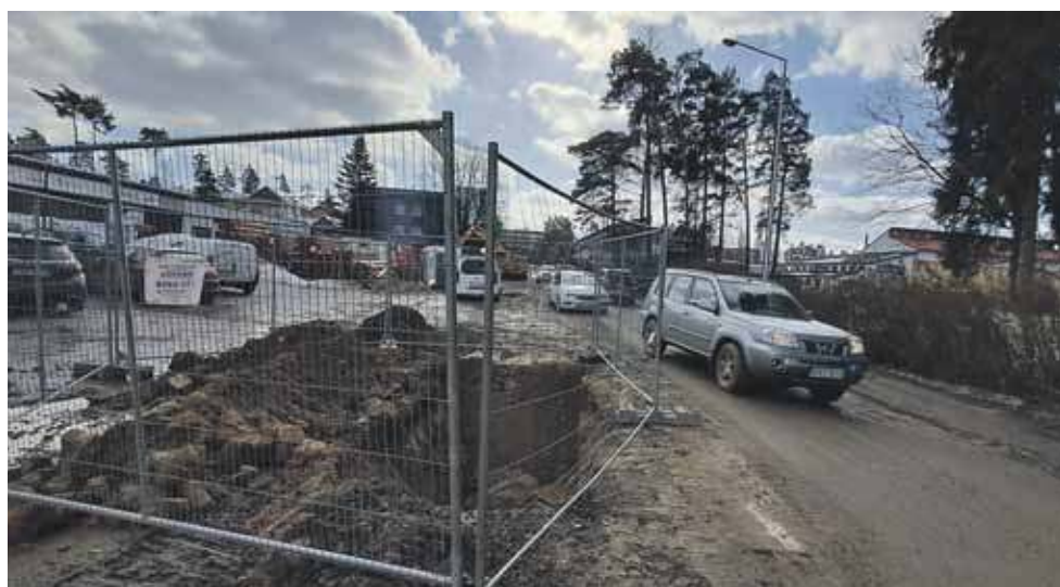
Pierwsze wykopy w powstającej Strefie Aktywności Gospodarczej.
