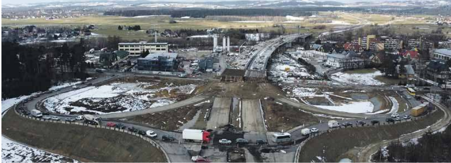
Węzeł Nowy Targ Zachód widziany z lotu ptaka.
