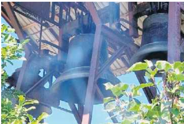
Dzwony przy sanktuarium w Jarosławicach dzwonią już ponad 30 lat. Teraz potrzebują renowacji
