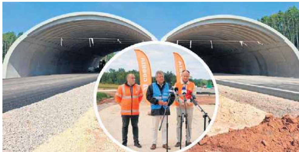
Mosty, wiadukty i asfalt. Tak wygląda półmetek budowy S74 od Mniowa do Kielc. Z postępami prac zapoznał się wojewoda świętokrzyski Józef Bryk
