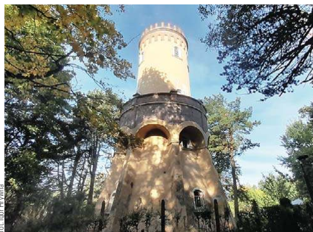
Wieża jest wysoka na 23 metry. Dla porównania: 10-piętrowy wieżowiec liczy sobie 30-35 metrów
