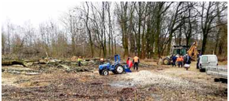
Wycinka prowadzona na Osiedlu Lotnisko tu ma powstać nowy budynek mieszkalny
