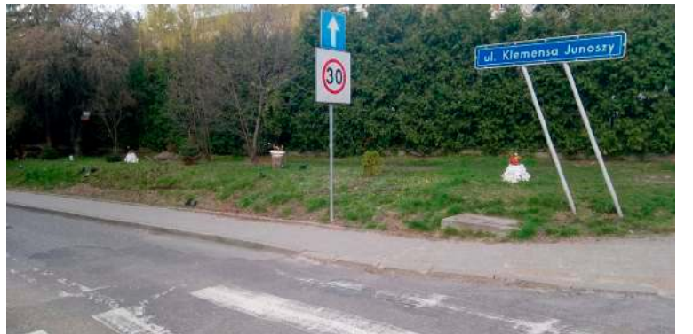
Na ul. Junoszy położony zostanie nowy asfalt na odcinku od posesji nr 12 do 49
