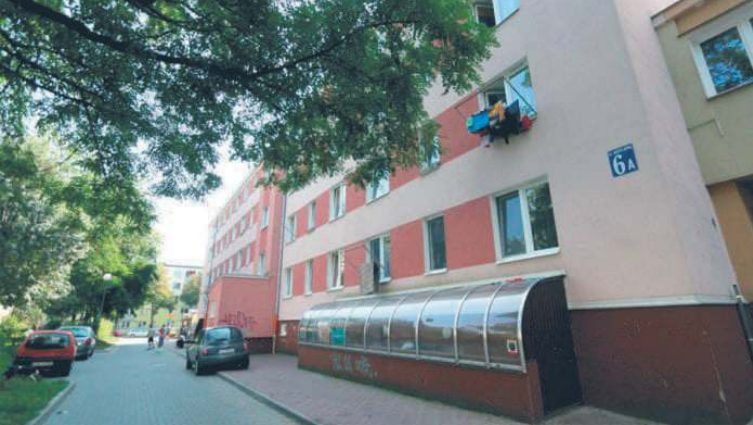
Ostatnie nowe lokale socjalne miasto oddało do użytku w 2010 roku adaptując na potrzeby mieszkalne budynek byłego hotelu robotniczego przy ul. Hotelowej 6a
