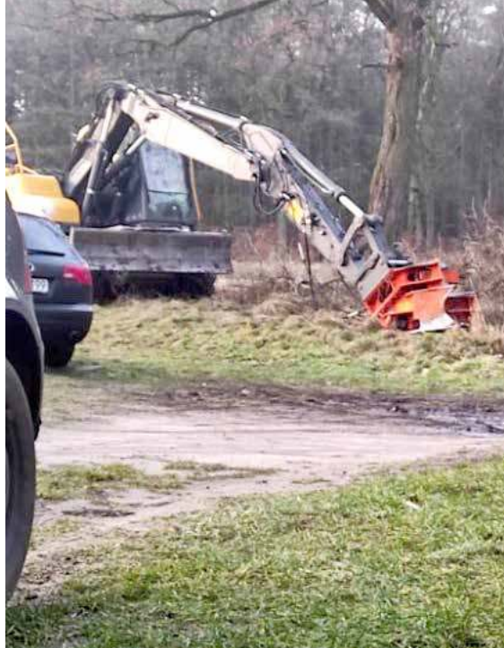
Niedaleko drogi widać również ciężki sprzęt przygotowany do pracy
