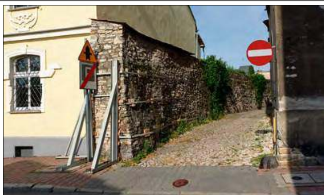
Z uwagi na postępującą destrukcję mur został zabezpieczony.
