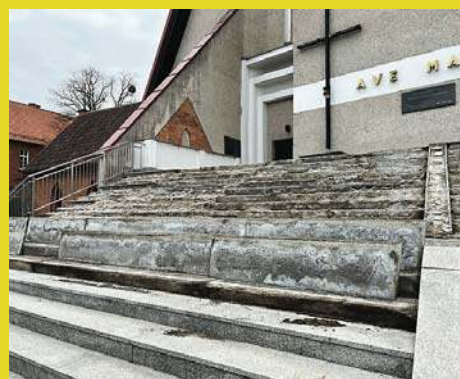
Burzą schody do kościoła | 4
