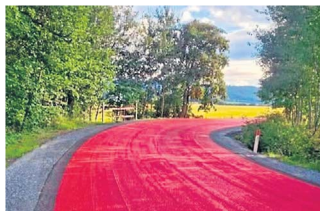
Specjalna powłoka w kolorze czerwonym ostrzega przed zakrętem i poprawia przyczepność auta do jezdni. W Czechach do bardzo popularne rozwiązanie.
