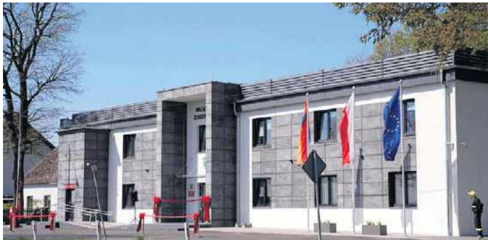
Stary budynek został gruntownie zmodernizowany, dobudowano nowe skrzydło.
