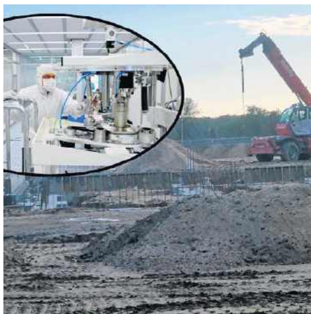
Teren inwestycji został już ogrodzony, a na plac budowy wjechał ciężki sprzęt. Trwają roboty ziemne, powstają też m.in. fundamenty przyszłej hali.
