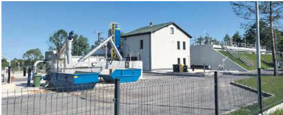
Zmodernizowana oczyszczalnia ścieków w Starych Siołkowicach
