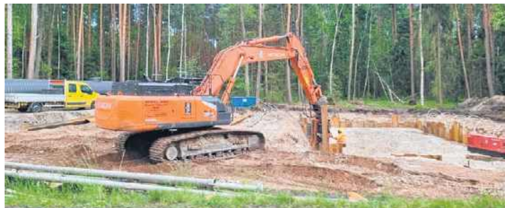
Generalna Dyrekcja Dróg Krajowych i Autostrad zapowiada, że prace zakończą się po wakacjach.
