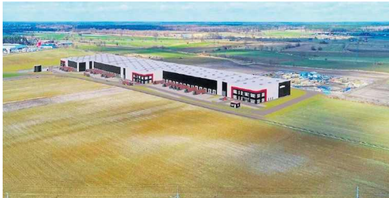
Budowana hala magazynowa w Chrzastowicach ma być gotowa jeszcze w tym roku.
