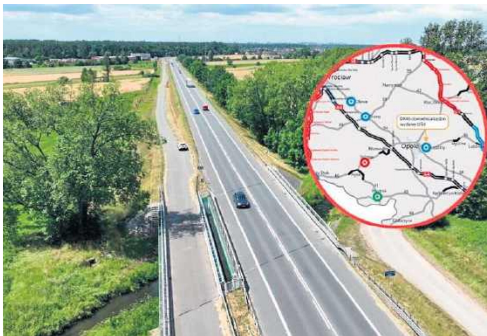
Obwodnica ominie Lędziny po stronie południowej i przebiegnie przez tereny leśne.
