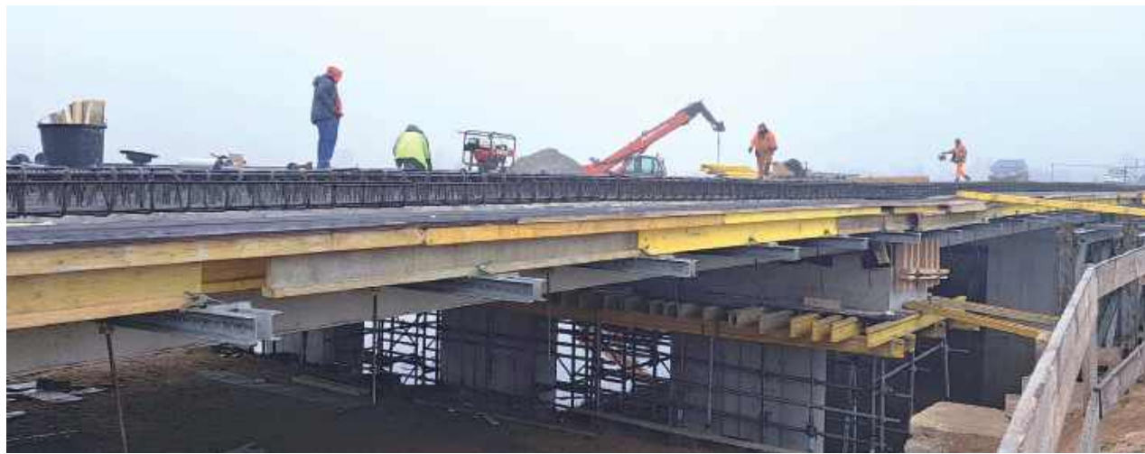
Jednym z elementów remontu na odcinku Wysokie-Rudniki jest budowa mostu
