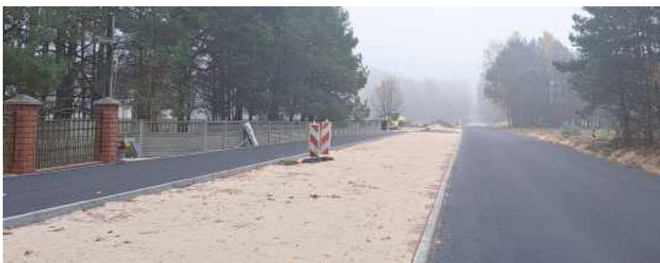
W ramach inwestycji, na drodze powiatowej powstaje m.in. ścieżka pieszko-rowerowa
