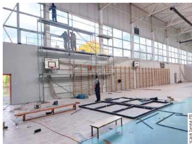
Trwa wymiana okien w sali gimnastycznej wraz z automatyką (gwarantującą możliwość uchyłu okien z poziomu podłogi)
