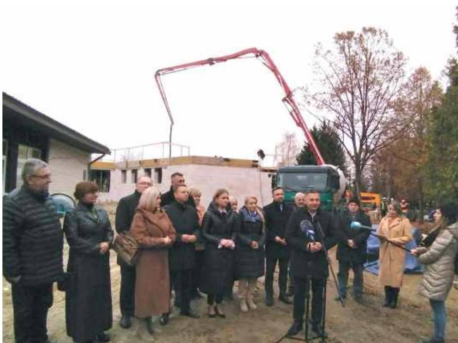
Konferencja prasowa na placu budowy
