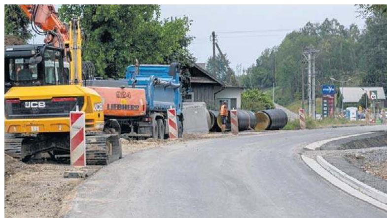
Inwestycja, która już zmienia krajobraz tej części regionu, jest jedną z trzech części rozbudowy drogi między Tyczynem a Dynowem
