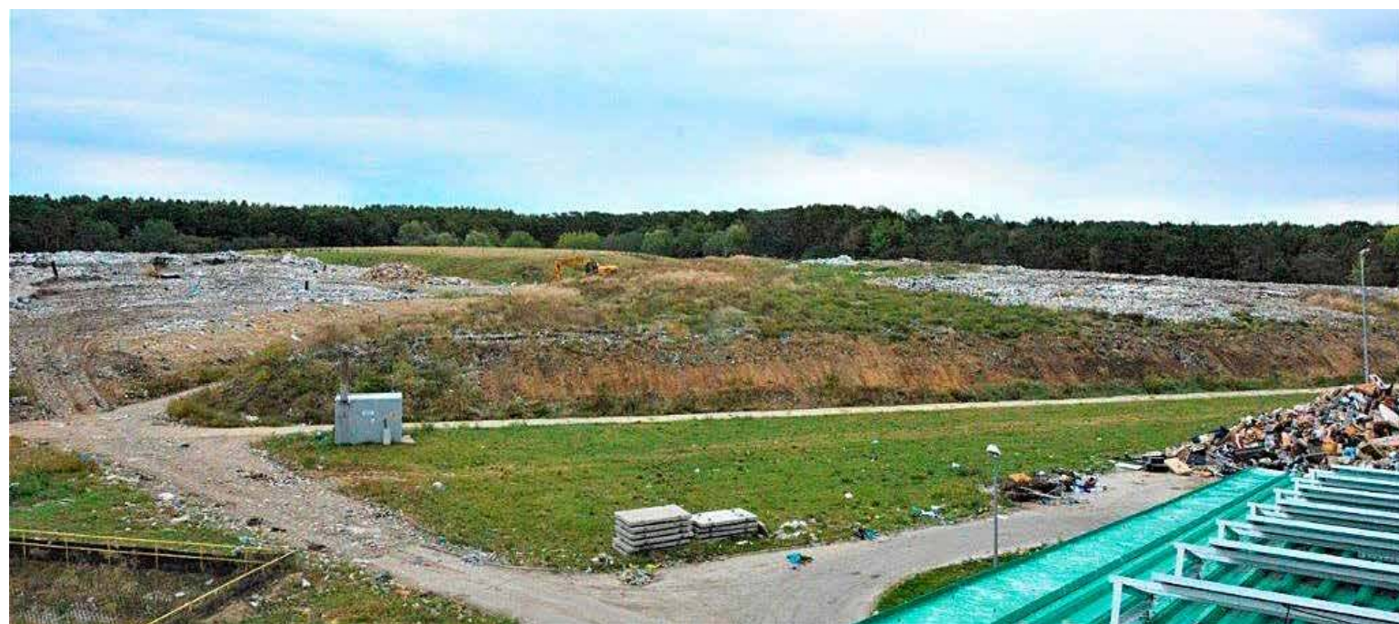
Rekultywacja jednej z kwater do składowania odpadów innych niż niebezpieczne w roku 2019. Foto. archiwum
