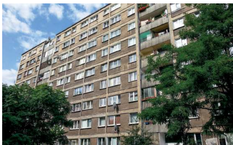
Płyty azbestowe zostały zdemonstrowane z budynków przy ul. Dobrej we Wrocławiu w 2017 r. | fot. mat. pras. UMIG Wrocław/d
