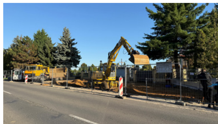
Wykonanie robót budowlanych nawierzchni zjazdu z drogi powiatowej do bramy Cmentarza Komunalnego w Brzegu Dolnym.
