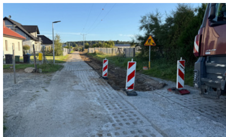
Przebudowa ul. Zbożowej w Brzegu Dolnym.
