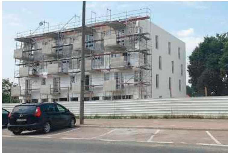
Jeden z nowych bloków powstaje nieopodal ścisłego centrum, między ulicami Wyszyńskiego, Kamińskiego i Gospodarczą
