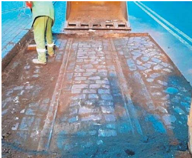
Dawne tory odsłonięte na ul. A. Kordeckiego
