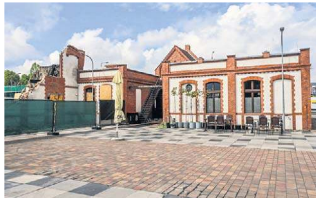
Główny budynek, w którym znajdowała się sala koncertowa Fabryki Lloyda spłonął niemal doszczętnie. Odbudowa nie mogła się do tej pory rozpocząć, między innymi z powodów formalnych
