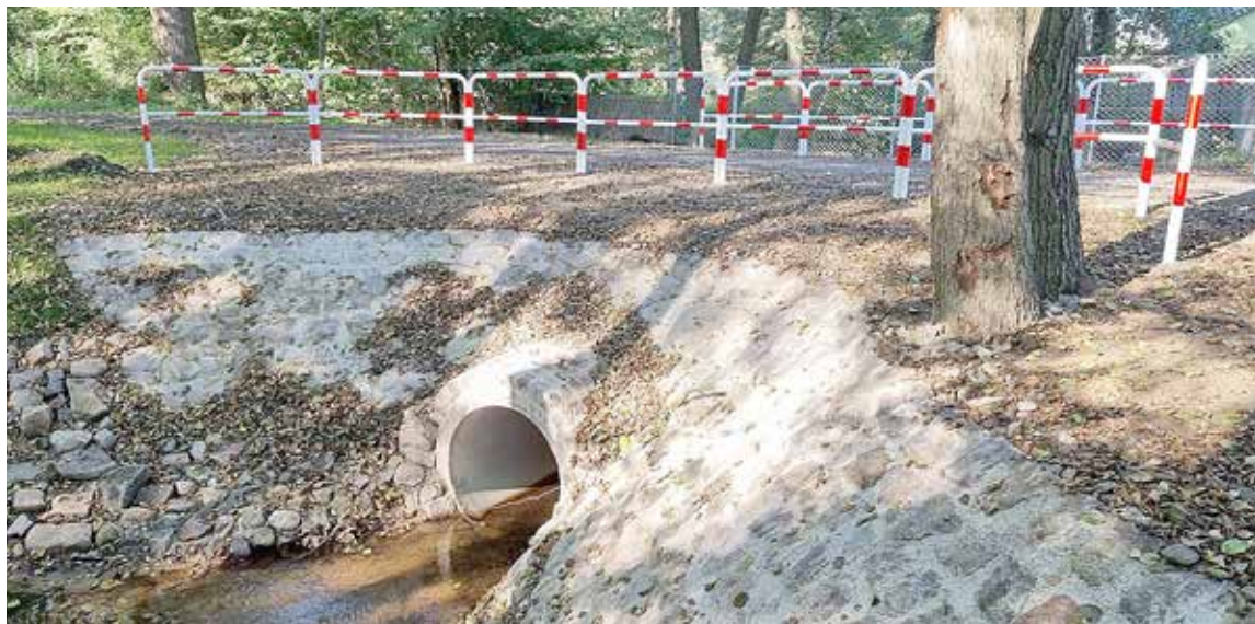
Przepust wodny w Boguszycach został ukończony we wrześniu br.
