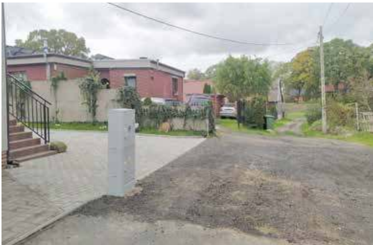
Skrzynka została umiejscowiona niefortunnie na środku placu manewrowego w pobliżu posesji
