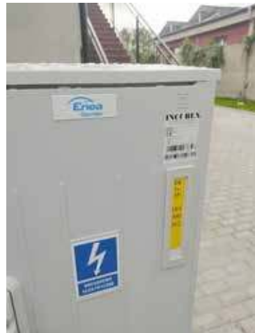
Skrzynka energetyczna została zamontowana przez pracowników ENEA zgodnie z opracowaną wcześniej dokumentacją
