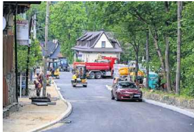
Dolna część ulicy Kasprusie zostanie otwarta dla ruchu w poniedziałek 7 września
