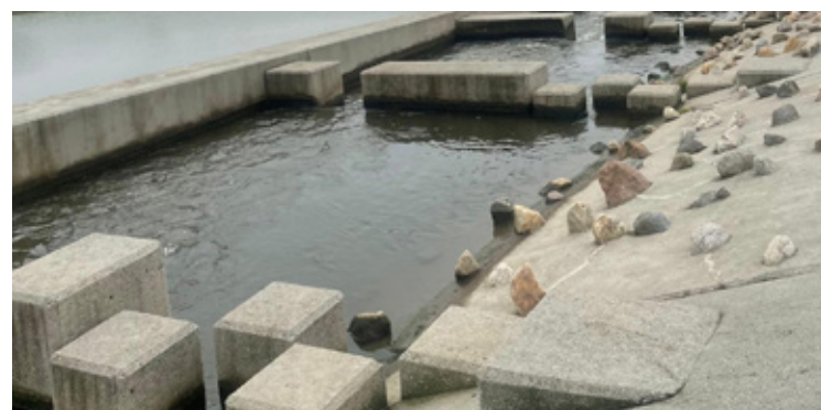
Na stopniu Malczyce mamy dziś trzy przepławki – lewobrzeżną, prawobrzeżną i bystrotek kaskadowy. To nowoczesne rozwiązania, które umożliwiają rybom wędrówkę w górę rzeki, m.in. dla tarła.
