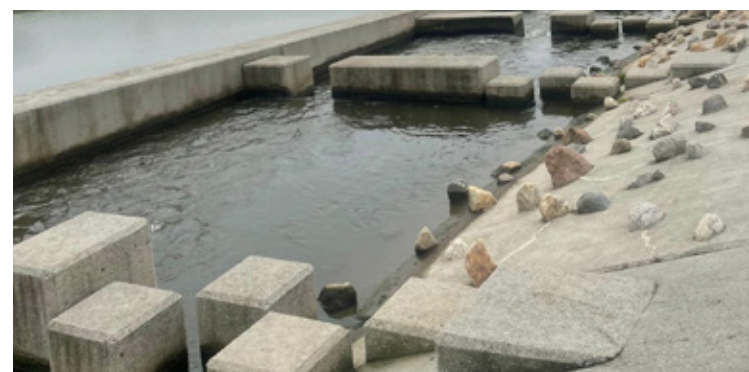
Na stopniu Malczyce mamy dziś trzy przepławki – lewobrzeżną, prawobrzeżną i bystrotek kaskadowy. To nowoczesne rozwiązania, które umożliwiają rybam wędrówkę w górę rzeki, m.in. dla tarła.
