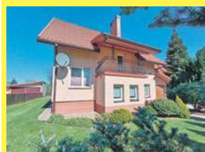
Dom przy ulicy Wyzwolenia, pow. 157,60 m 2 , 604 494 489
