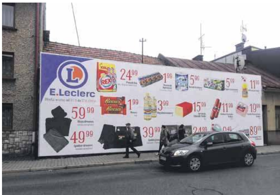
Reklama przy Szaflarskiej stoi od połowy sierpnia. Mimo nakazu rozbiórki.
