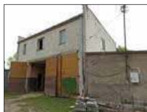
Tak wyglądał budynek przed remontem. Obecnie mieści się w nim spółdzielnia socjalna
