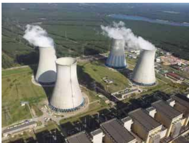
Foto 17. Schładzanie ogromnych ilości wody z elektrowni w chłodniach kominowych, woda oddaje ciepło do powietrza, źródło: galeria fotografii „Kom Spec”, chłodnie elektrowni Bełchatów
