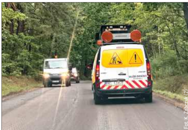
Kilka dni temu drogowcy zrywali asfalt.
