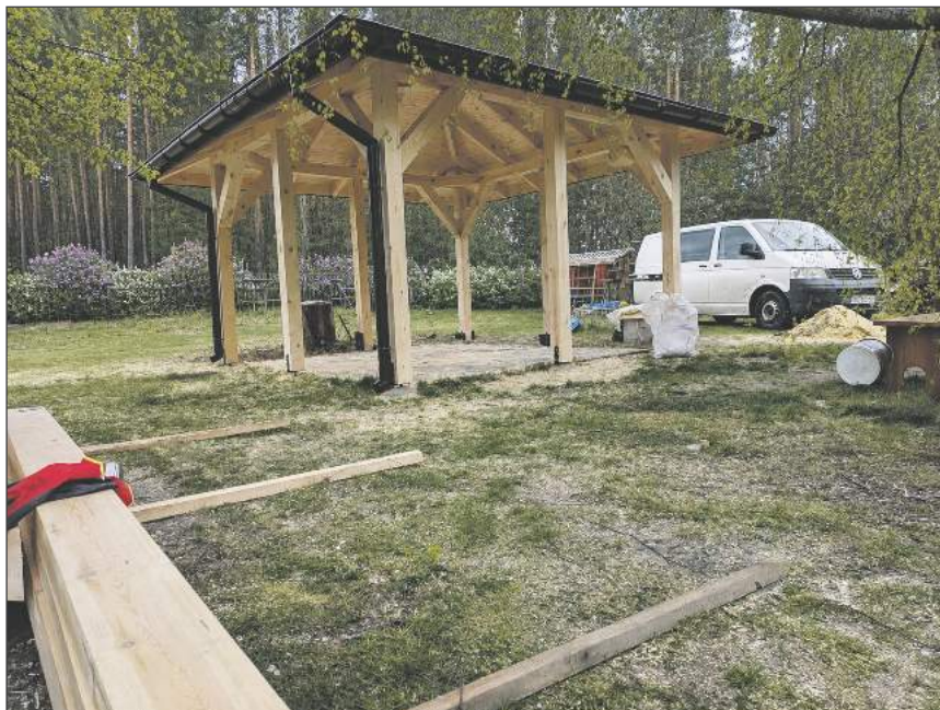
■ Budowa altany 3,5 x 3,5 m sprawnej ekipie zajmuje około 2 dni
