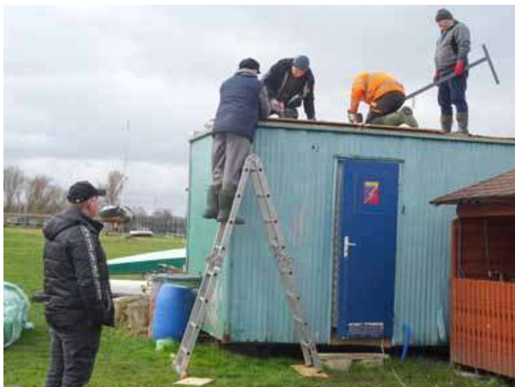
Naprawiają dach kontenera
